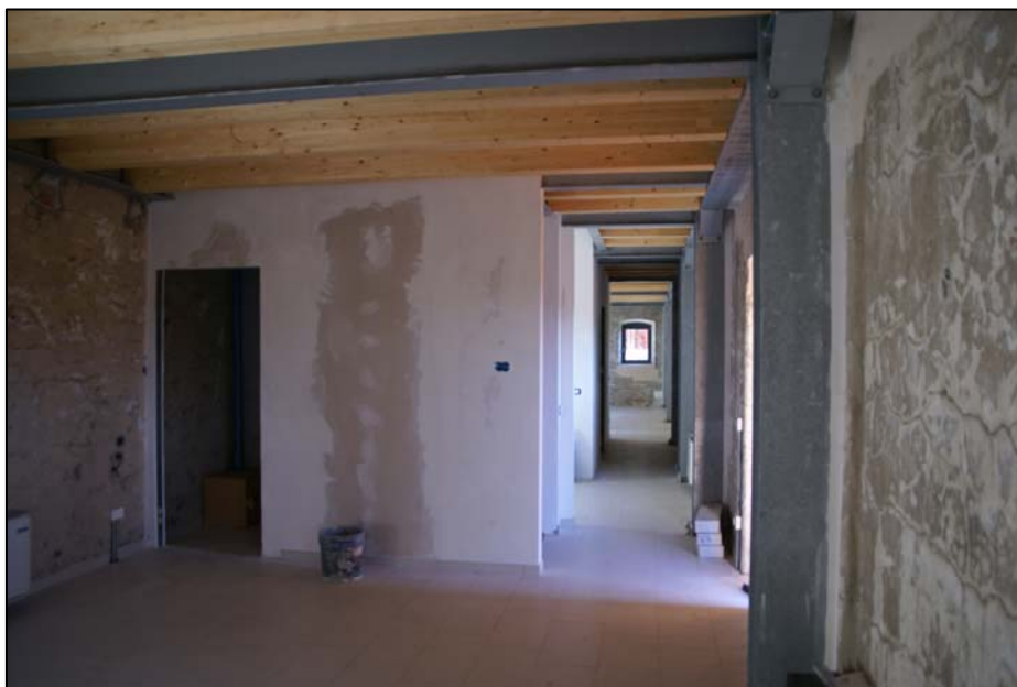
FOTO 2 Interno della caserma, al livello terra, verso il corridoio di accesso al fabbricato.
