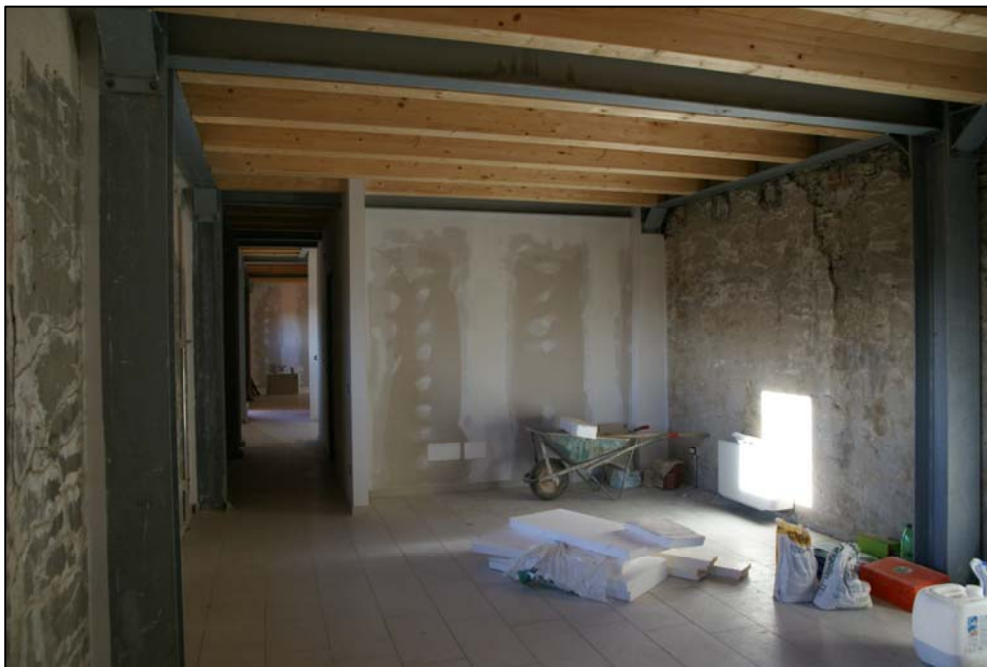
FOTO 3 Interno della caserma, al livello terra, verso il bagno disabili.
