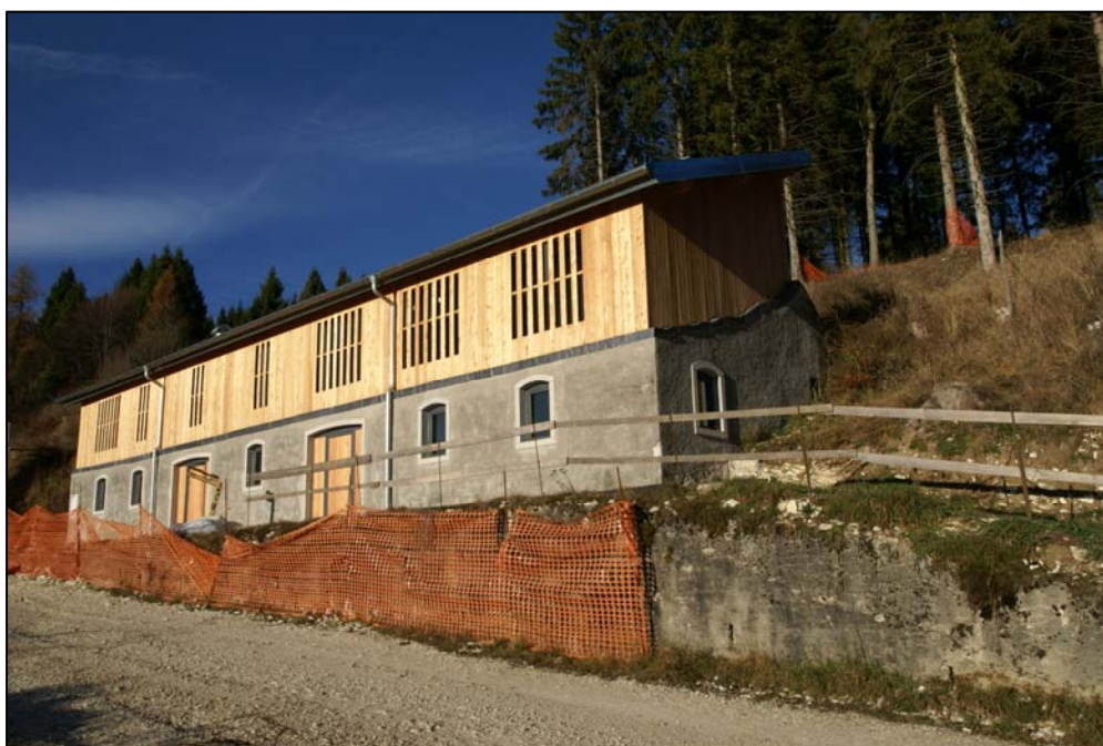
FOTO 4 Muro in materiale litoide, lungo la “strada militare Col de Gnella-Cima Campo”.
